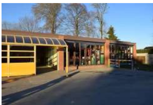
Ecole fondamentale (Acc. -P2)
